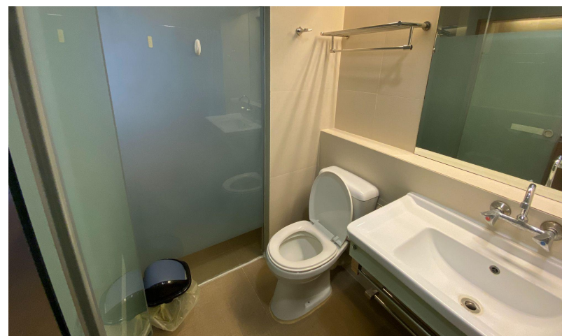
乾湿分別エリア & 温冷シャワー付きトイレ
